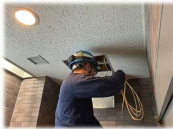
▲某現場にて配線中
