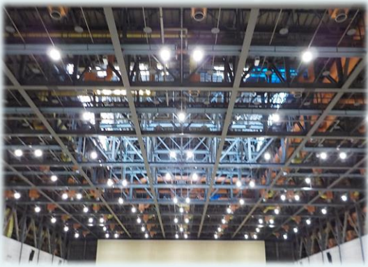
▲ 既存展示場 照明器具落下防止のため 天井裏から1台1台増締確認を行います
