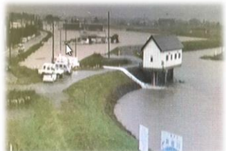
▲10月23日8時頃の井田川。川の増水と左後方の浸水の様子（井田川ライブカメラより）
