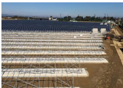
▲パネル搬入状況
