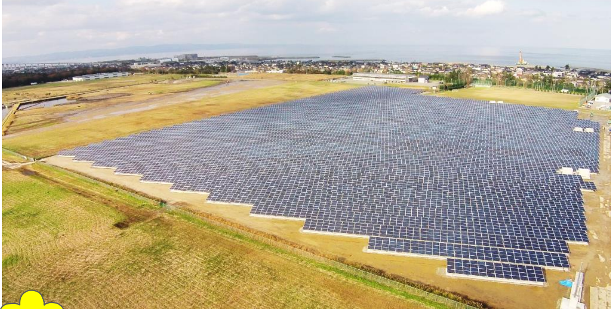
▲射水市海老江地区(富山新港火力発電所石炭灰処分場A区画)
