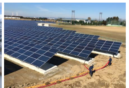
▲幹線ケーブル埋設状況
