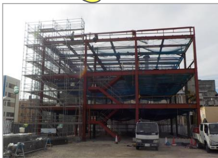
▲施工現場の様子
