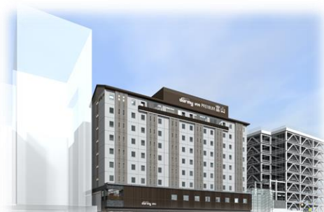
▲国道41号線側外観 完成イメージ
