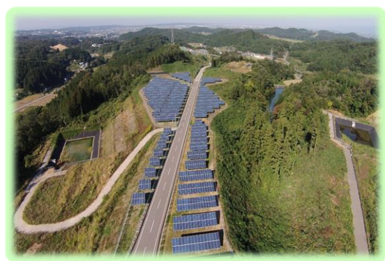
▲広大な敷地に設置された太陽光発電パネル (Nix八尾ソーラーパワー様: パワコン出力1,260KW 無人ヘリにて撮影)
