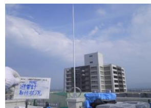
▲ 避雷針設置状況
