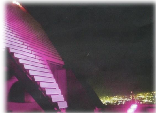
▲ 屋上での点灯試験調整の様子
