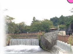
常願寺川左岸の常西合口用水
