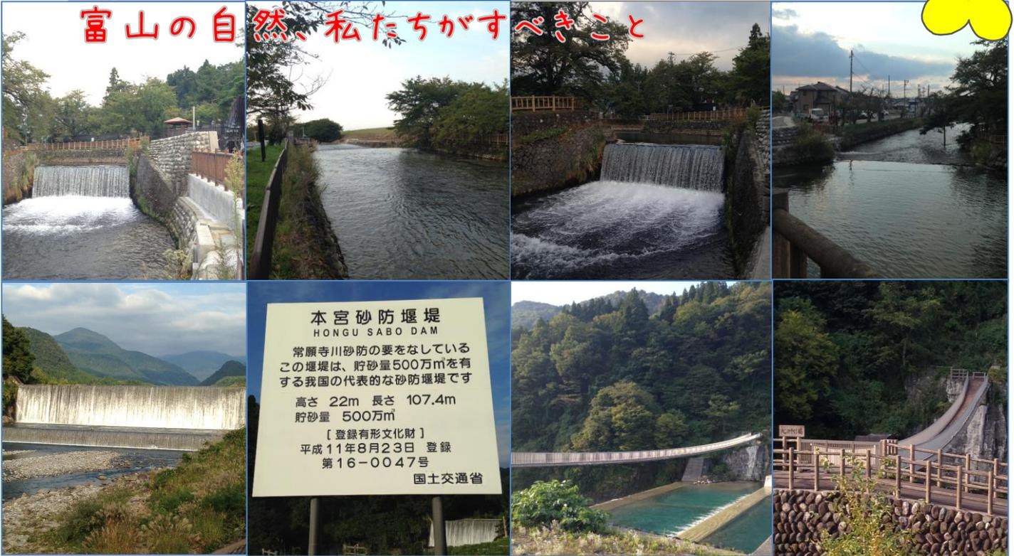
▲上段：テ・レイケによって完成された常西合口用水。川から直接水を引く取水口を1ヶ所にまとめています
